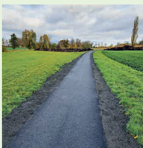
Sanierung des Rad- und Gehweges zwischen Döhlen und Quesitz, Kosten ca. 60.000 Euro Der Weg erhielt eine neue Deckschicht und das Bankett wurde hergerichtet.
